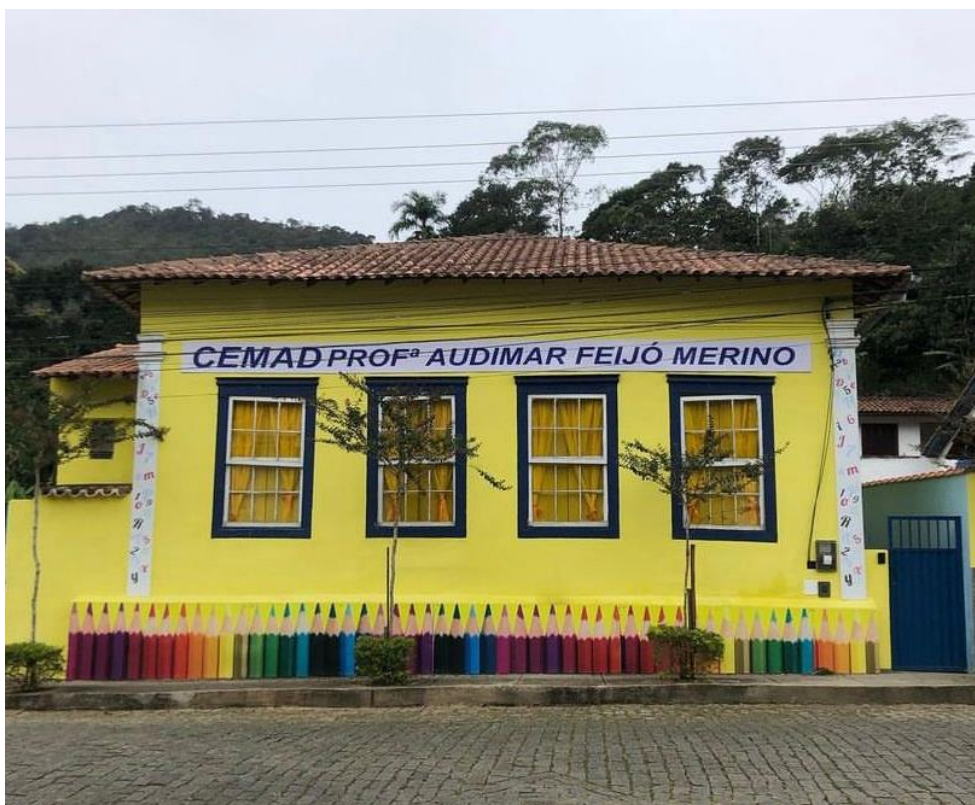
Figura 28 - Fachada do Centro Educacional de Madalena.
